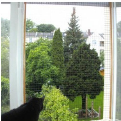
**Einfache Fenstersicherung:** Dieses Beispiel zeigt einen mit Volierendraht betackerten Rahmen, der mit kleinen Schrauben in das alte Holzfenster geschraubt wurde. Gibt es keine Möglichkeit zu bohren, wie z.B. bei Kunststofffenstern oder in der Mietwohnung, kann man die Rahmen auch mit kleinen Winkeln in die Rahmen einhängen und festziehen. Dazu sollte
